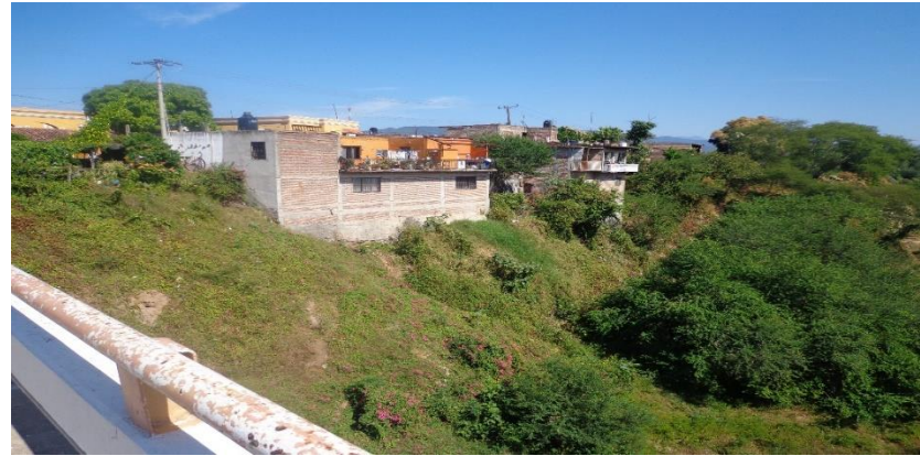
Imagen V.2.11.1.11 Vista desde el punto 2 hacia aguas arriba del Río, observando el desnivel existente en la margen derecha del río.
