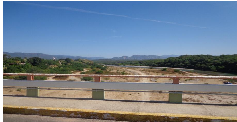
Imagen V.2.11.1.13 Vista desde el punto 3 hacia aguas arriba del Río, observando el desnivel existente en la margen derecha del río, Así como el cauce.
