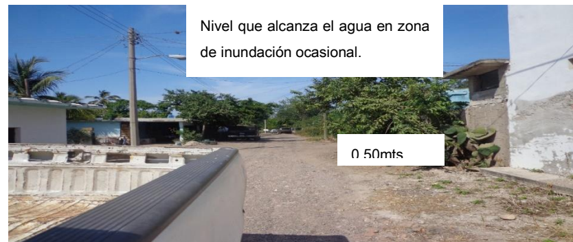
Imagen V.2.11.1.27 Vista desde el punto 5 hacia el interior del poblado de Dimas, en la cual se señala el nivel que alcanza el agua en esa área.
