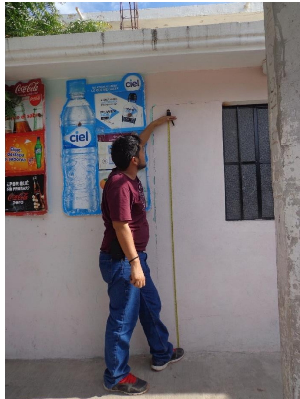
Imagen V.2.11.1.44 Vista desde el punto 5 hacia la calle Santos degollado, en el poblado de Piaxtla de Abajo. En la cual se puede observar el nivel alcanzado por el agua durante la inundación de 1993.
