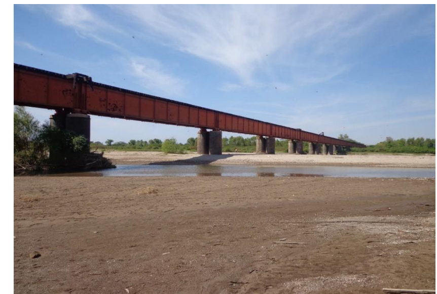
Imagen V.2.11.1.19 Vista desde el punto 2 hacia aguas abajo, observando el puente de ferrocarril.
