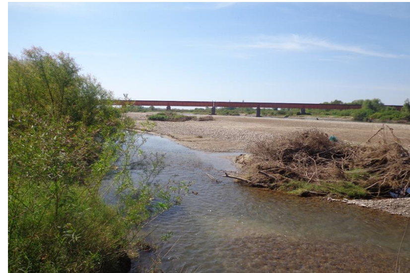
Imagen V.2.11.1.17 Vista desde el punto 1 hacia aguas abajo, observando el puente de ferrocarril.
